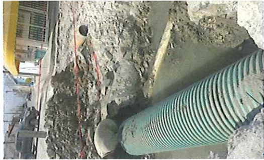
REPARACION TUBERIA DE DRENAJE
