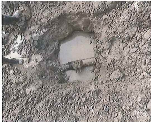
REPARACION LINEA DE AGUA
