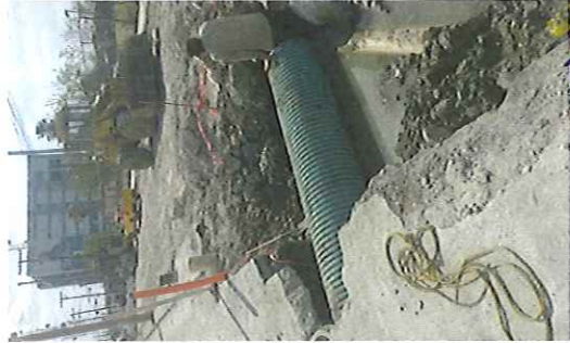
REPARACION TUBERIA DE DRENAJE
